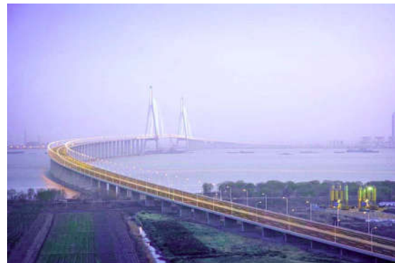
Mô hình cầu Sutong – cầu treo dây văng nhịp dài nhất thế giới ở Trung Quốc
